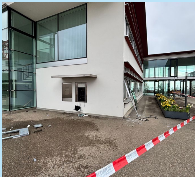
Sprengung Bankomat Raiffeisenbank Mörschwil
